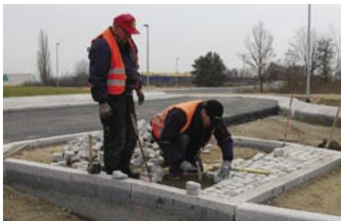
Mitarbeiter der Firma Matthäi bei Pflasterarbeiten
