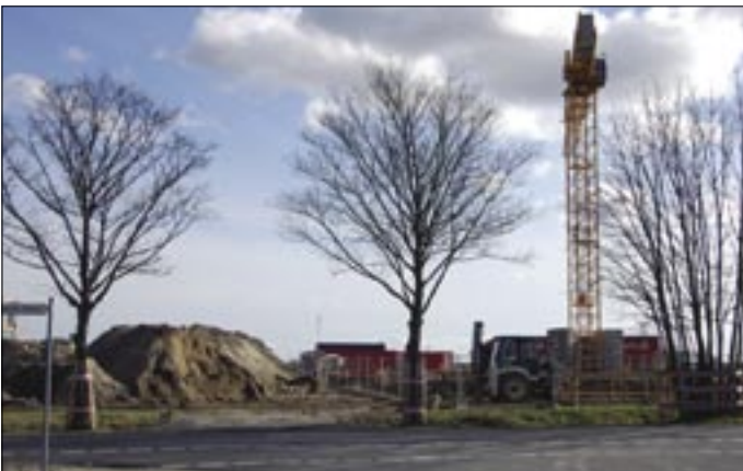
Baustelle des Windkanals
