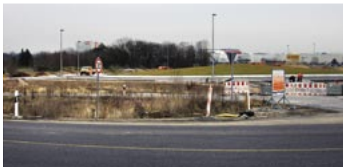
Kreisverkehr in Waltersdorf, wichtiges Infrastrukturprojekt der Gemeinde
